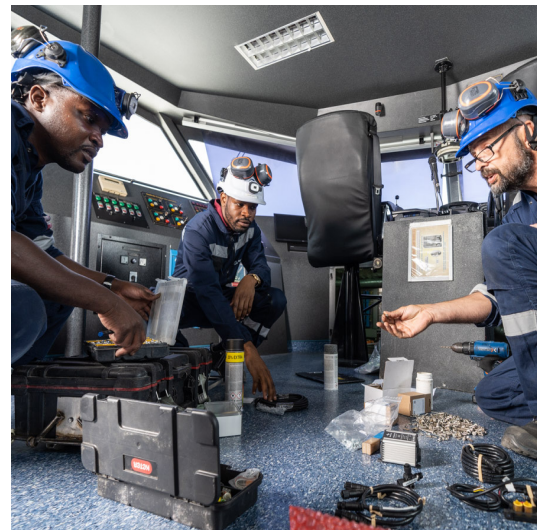
Colaboradores na instalação de componentes do ferry elétrico, Salicornia, GRUPO ETE.
